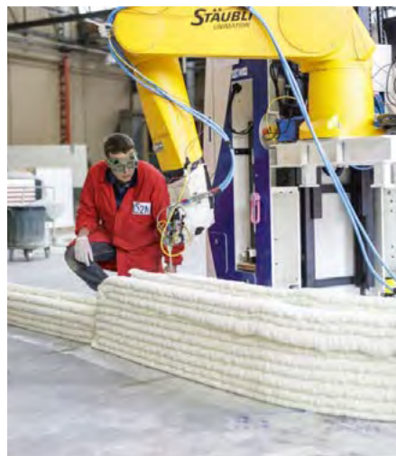
Impression 3D d'une maison avec un robot mobile
