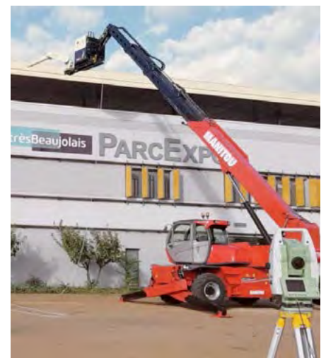
Traitement de façade robotisé avec un robot sur un chariot télescopique
